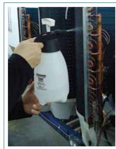
Protection anti-corrosive appliquée à l'intérieur de l'unité
